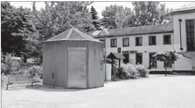
Die Stadt Flöha hat jetzt vor dem Flöhaer Bahnhof eine öffentliche Toilettenanlage.
