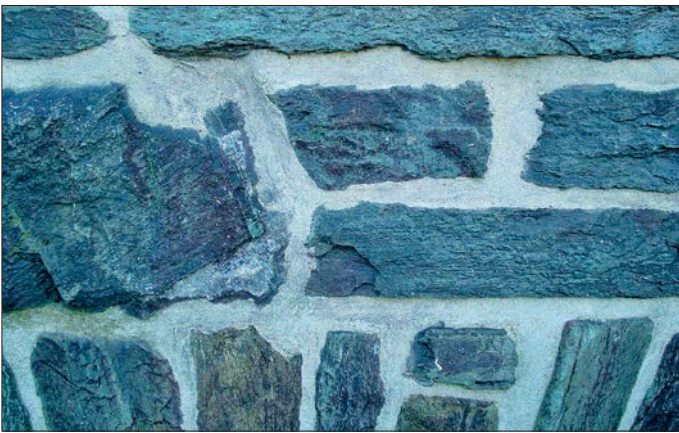
Grundmauer aus Hornblendeschiefer vom Heidelerchenbruch am Flöhaer Bahnhof. Foto H. Kroh
